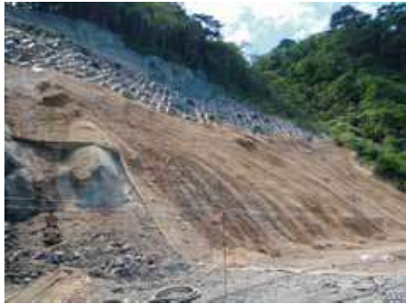
写真-3 連続繊維補強土の施工 (H21.8.26)
