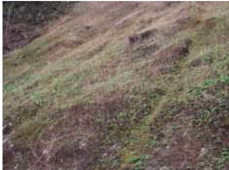
写真-7 法面表面の状況 (H23.5.10)
