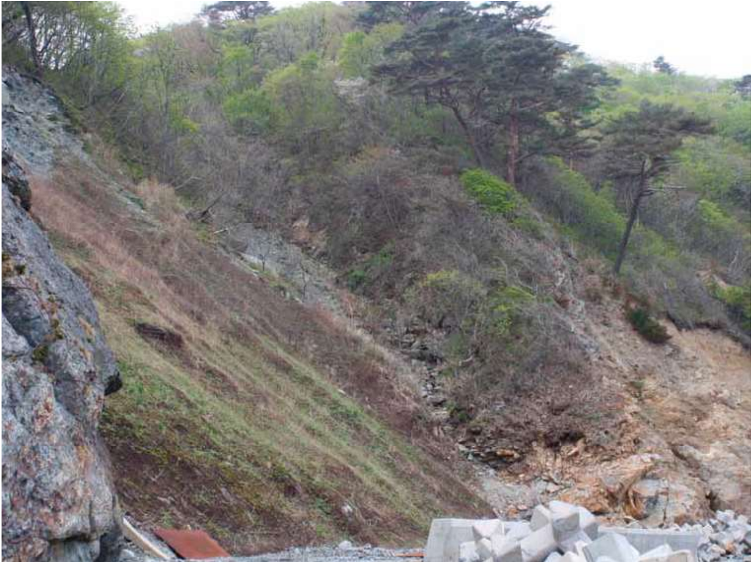
写真-1 地震の揺れと津波のなか、崩壊を免れたジオファイバー工法施工法面（岩手県久慈市三崎）
