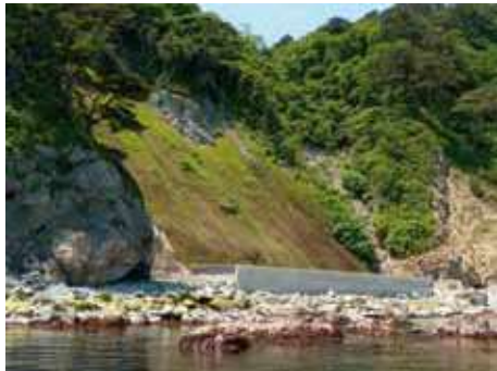
写真-4 施工後の斜面は緑に (H22.6.26)
