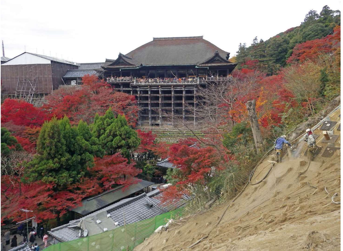
写真-1 連続繊維補強土施工状況
