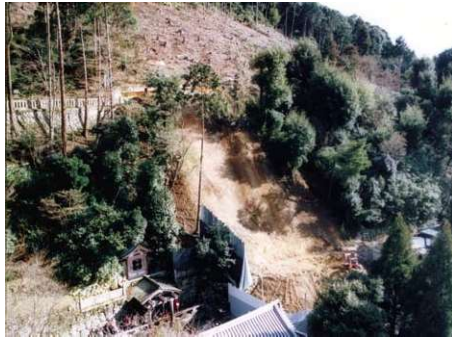
写真-2 平成11年の斜面崩壊
