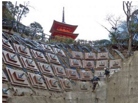
写真-6 子安塔直下斜面での施工状況
