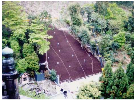
写真-3 ジオファイバー工法により復旧
