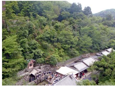
写真-4 見事に緑の斜面に（施工後12年）
