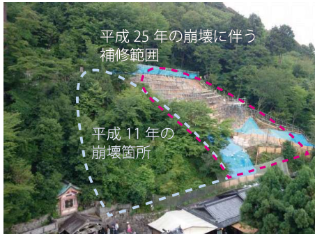
写真-5 ジオファイバー施工状況（平成26年）
