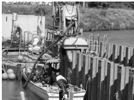
写真-1 現場での施工状況
