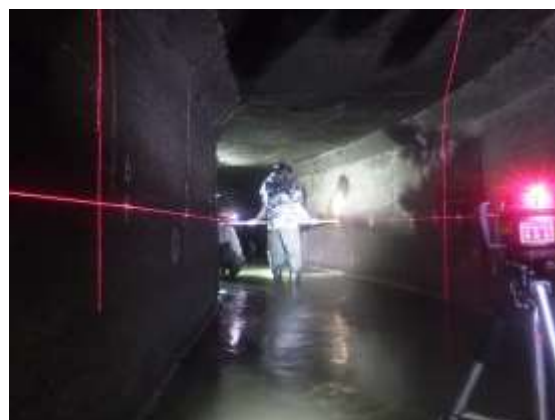
写真-3 施工前の管内測量
