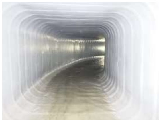
写真－４ 施工後の管内状況
