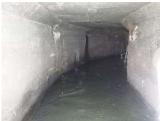
写真-2 施工前管内状況
