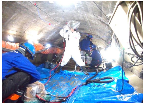
ウレタン注入状況
