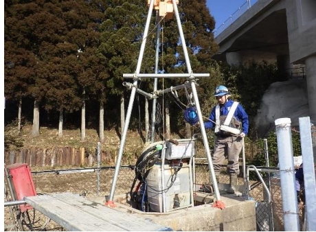
使用機材坑内搬入状況
