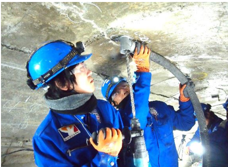
覆エコンクリート削孔状況
