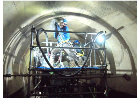
ウレタン注入状況
