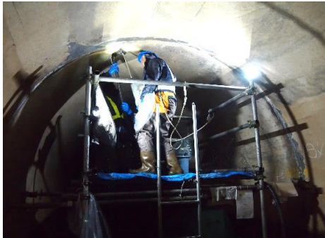
覆エコンクリート削孔状況
