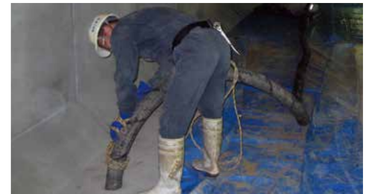
底版モルタル充填工例
