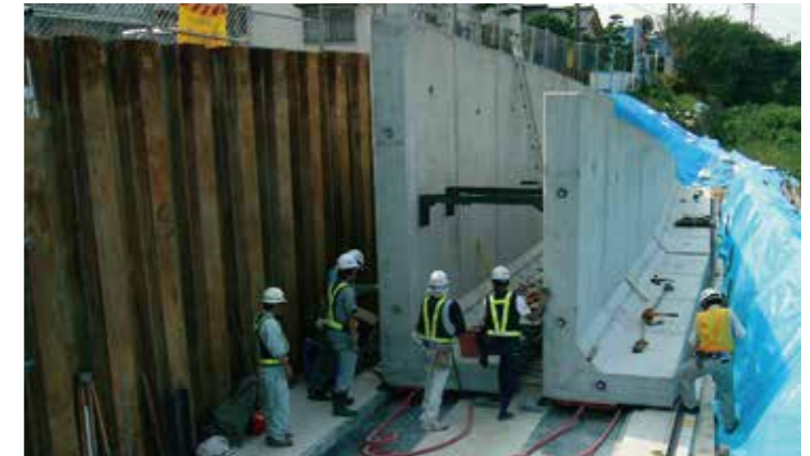
L型部材の連結施工例 [w=11.6t]
