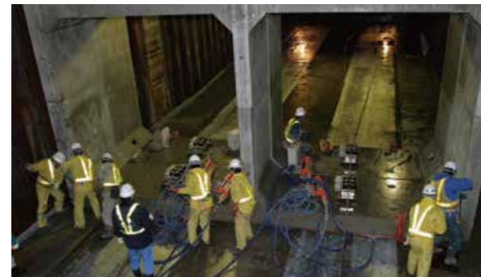
連結施工例 (2 函体連結) [w=67.4t]
