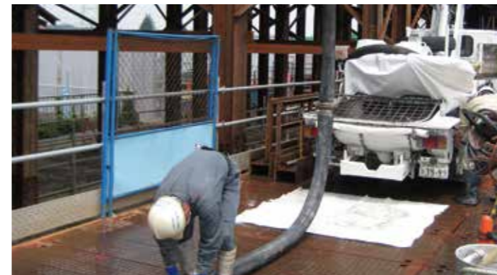
コンクリートポンプ車配管状況例
