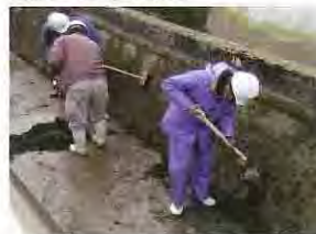
NSアグリモルタル(Hi)下塗り
