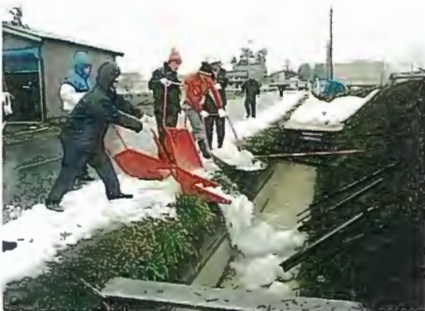
NETIS HR990081-A 流雪溝(排水路)
