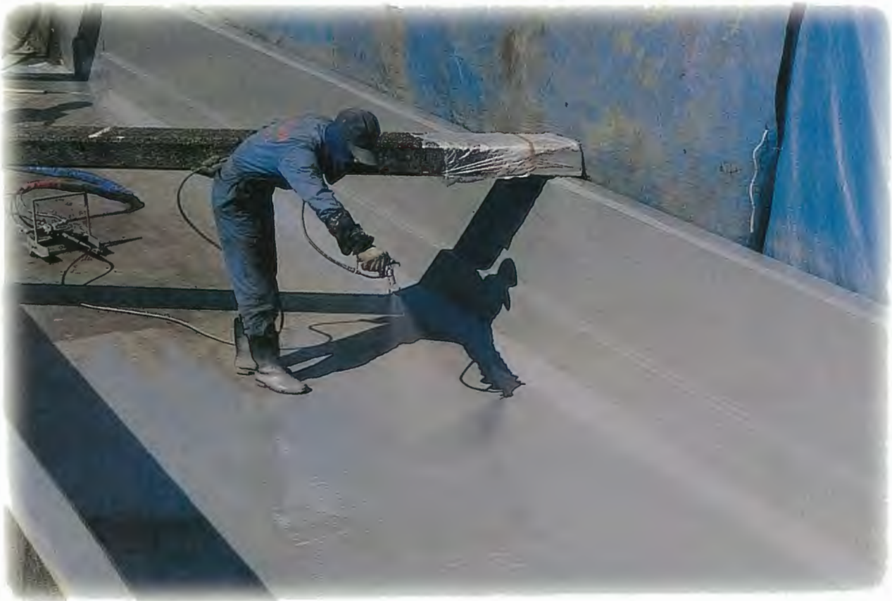
OMライニング施工中
