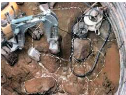
発進立坑の巨石
