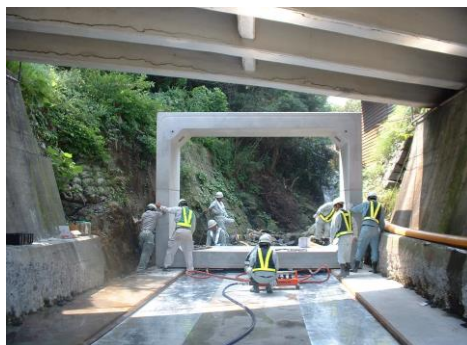
■人力による道路橋桁下の施工例
