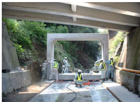
■人力による道路橋桁下の施工例
