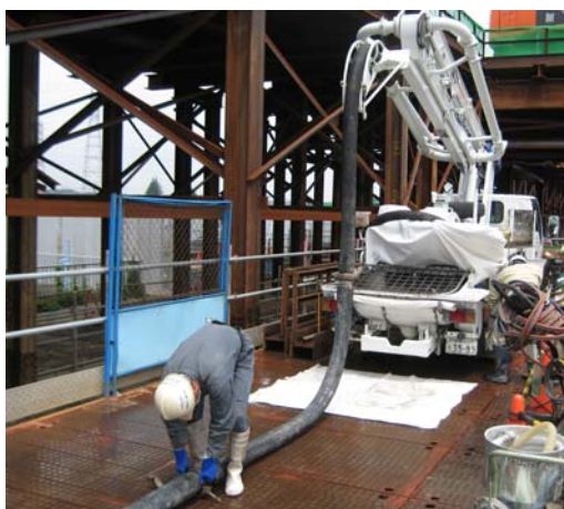
写真一解 4.8.1 コンクリートポンプ車の配管施工例
