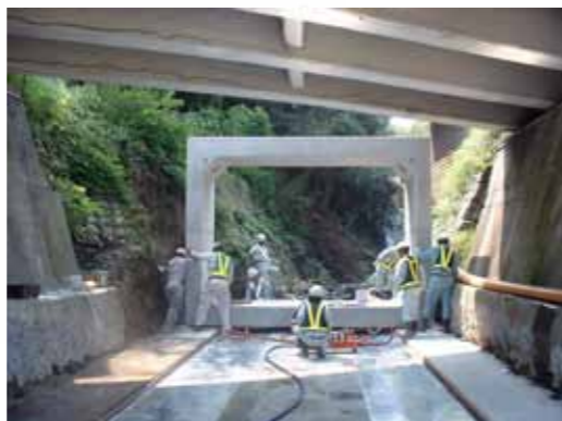
人力により道路橋の桁下を移動した例
