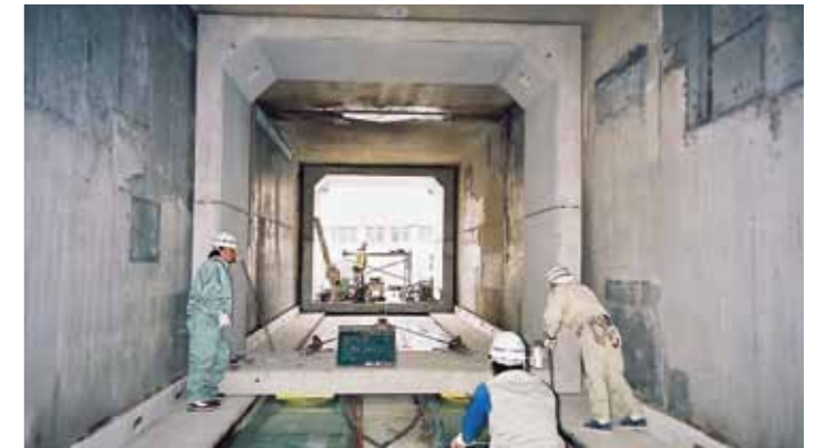
狭隘部分の施工例 [w=15.8t]
