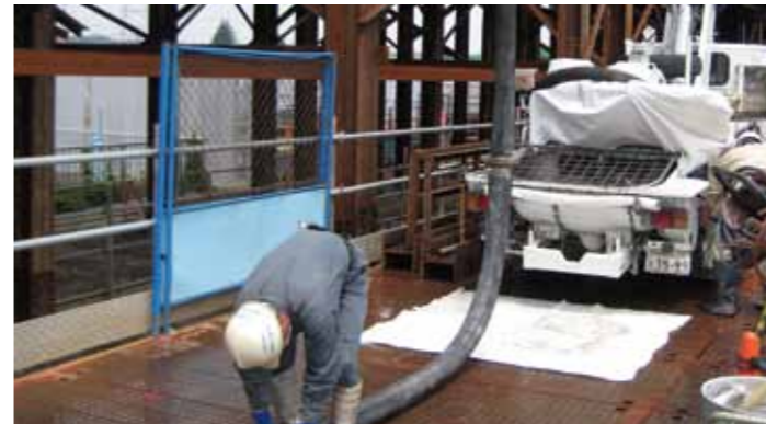
コンクリートポンプ車配管状況例
