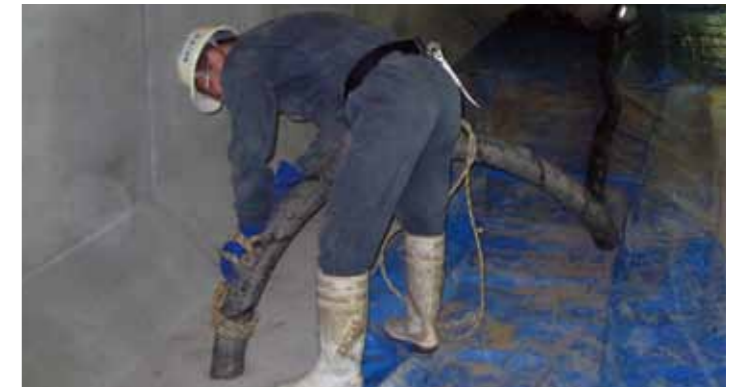
底版モルタル充填工例
