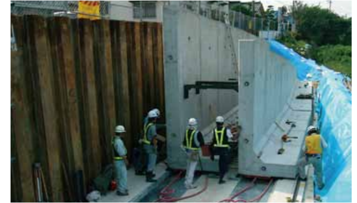
L型部材の連結施工例 [w=11.6t]
