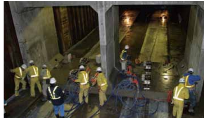
連結施工例 (2 函体連結) [w=67.4t]
