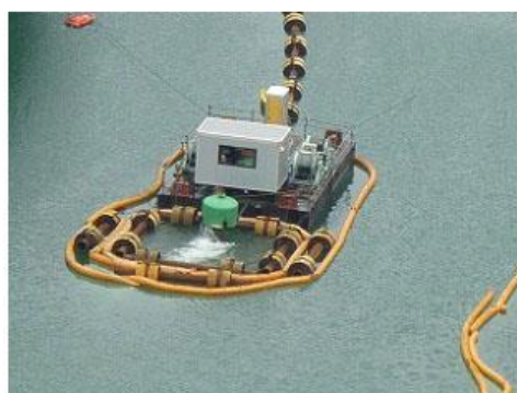
3) 輸送管先端に減衰器を設置
