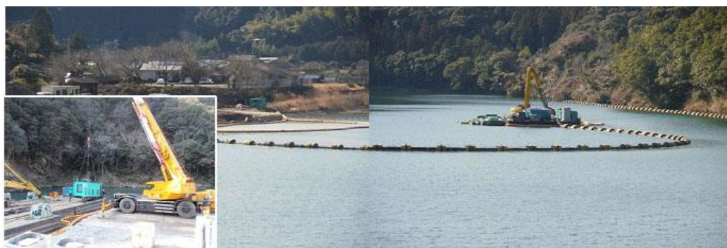
1, 2) ユニットフロート台船に特殊エジェクターシステムを設置し, 輸送管を配管
