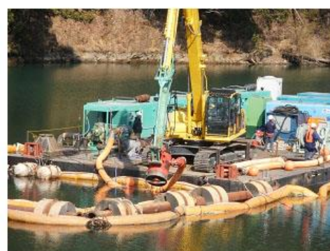
4) システムを起動して吸引作業を実施
