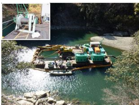
7) ウインチを操作して台船を移動
