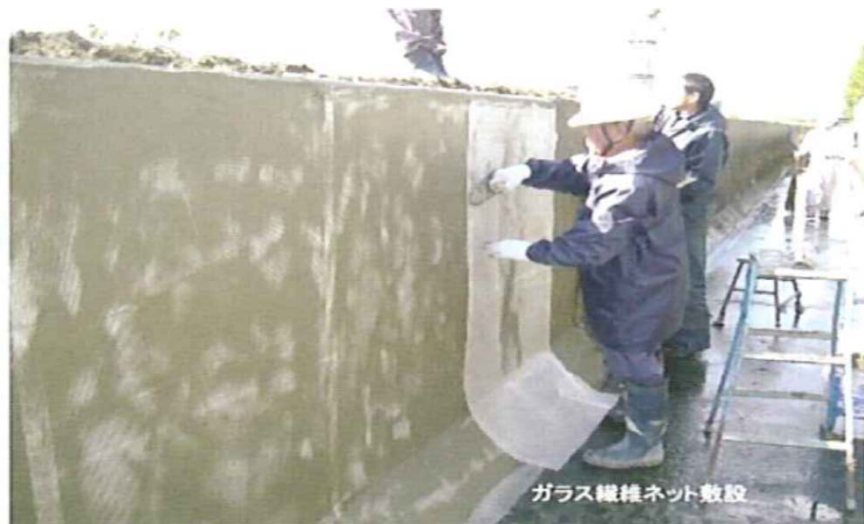
ネット伏せ込み工
