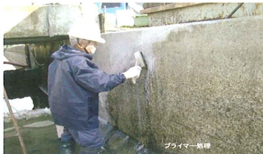
プライマー処理工
