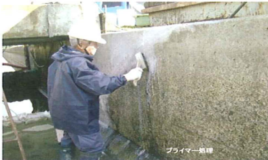
プライマー処理工
