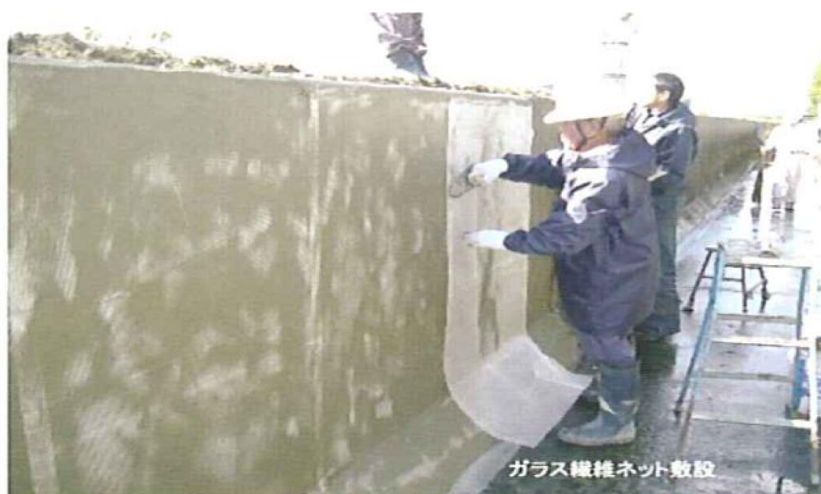
ネット伏せ込み工
