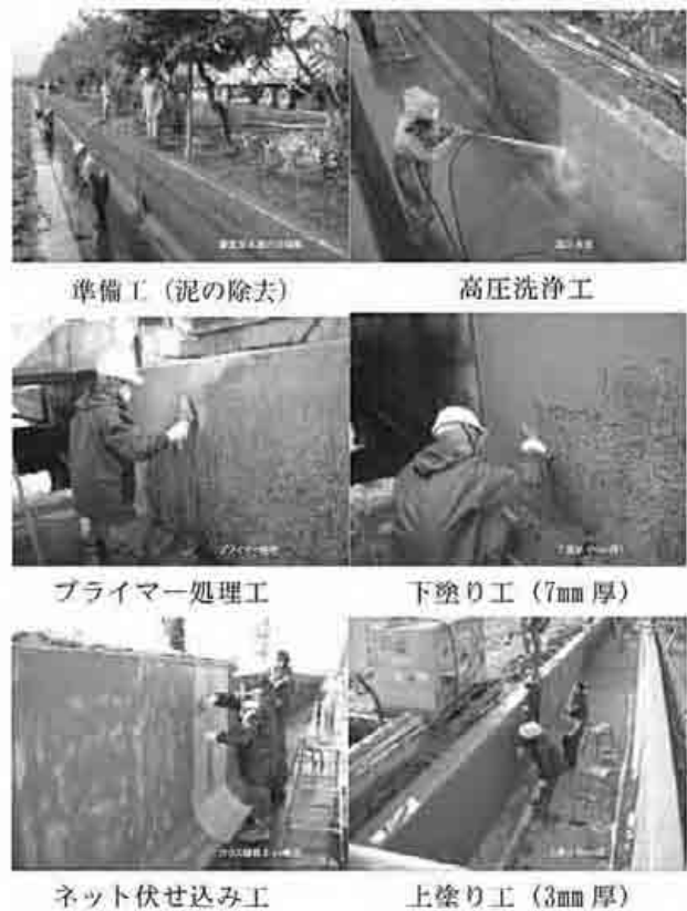
(写真-5) NSアグリコート工法の施工
