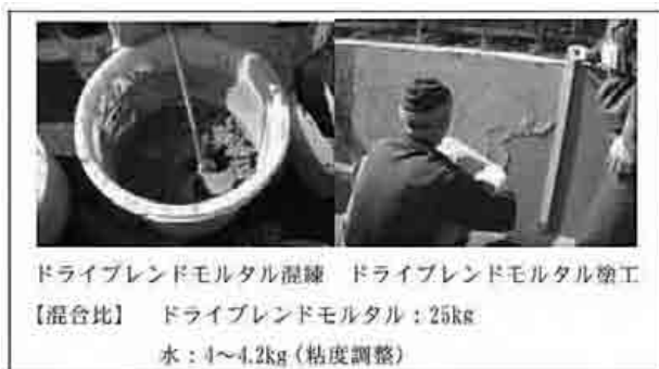
(写真-4) ドライブレンドモルタル施工状況
