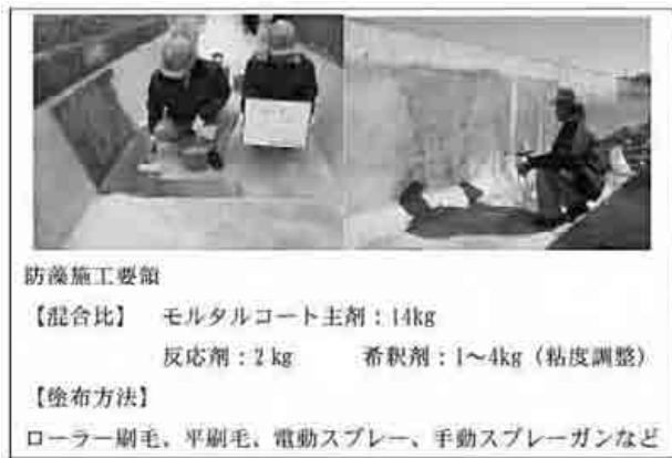
(写真-3) モルタルコート施工状況
