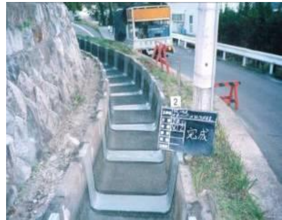
【目地漏水防止補修事例】
