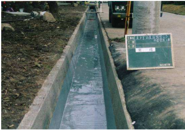
写真1 塗装流雪溝 施工直後
