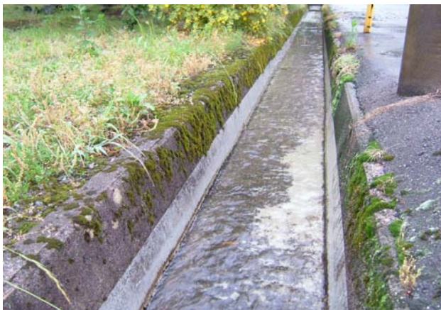
写真2 塗装流雪溝 13年経過状況
