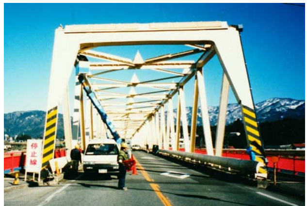
写真5 橋梁トラスの落雪対策
